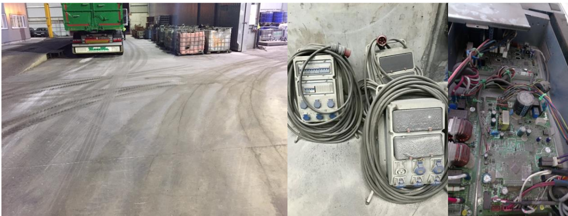
Fuente: Autoridad Portuaria de Bilbao; muestras de superficies y equipamiento deteriorados.
