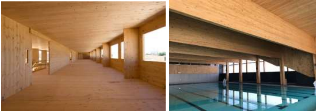
1. irudia. CLT eraikina ( Cross Laminated Timber ), eta MLE (Zur Ijeltu Kolatua) habeak dituen estalkia.
